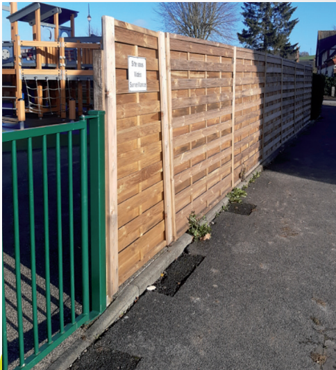
Remplacement de la clôture de l'aire de jeux
